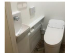
【店舗】清潔感のあるトイレに短期間でリフォーム トイレ
