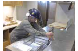
水栓金具の取付工事
